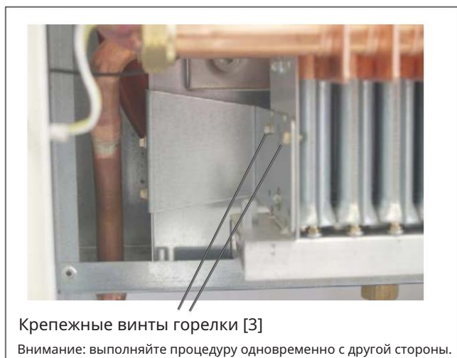
Изображение: Чистка газовой горелки
