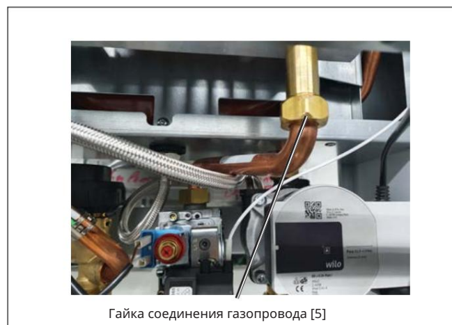
Изображение: Чистка газовой горелки
